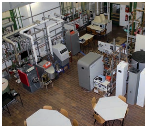
Blick ins Heizungslabor
