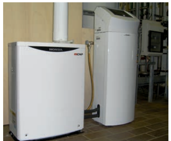
1-kW-Mikro-BHKW im Labor für Gas- und Verbrennungstechnik
