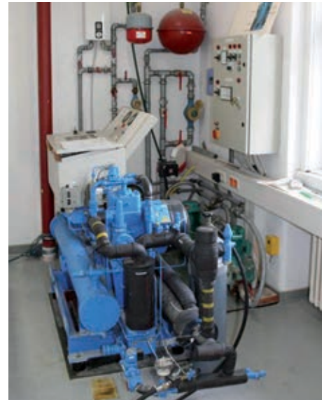
von Links: Mini-BHKW, R 134a Kompressions-KM, Adsorptionskältemaschine ACS 08, NH3-Kompressionskältemaschine ILKA
