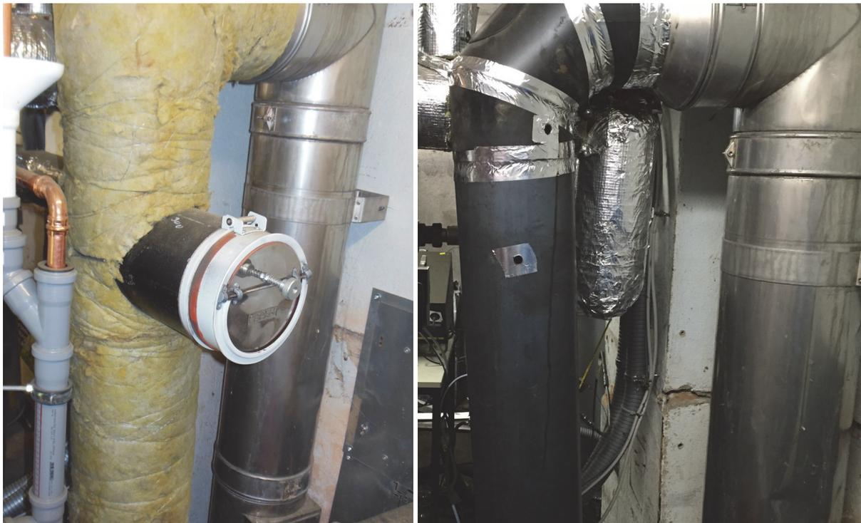
**Abbildung 9: Vorhandenes wärme gedämmtes Rauchrohr mit Zugbegrenzer (links); Neu eingepasstes Rauchrohr (ohne Wärmedämmung) mit Bohrungen für die Messsonden der Abgasanalytik (rechts)**
